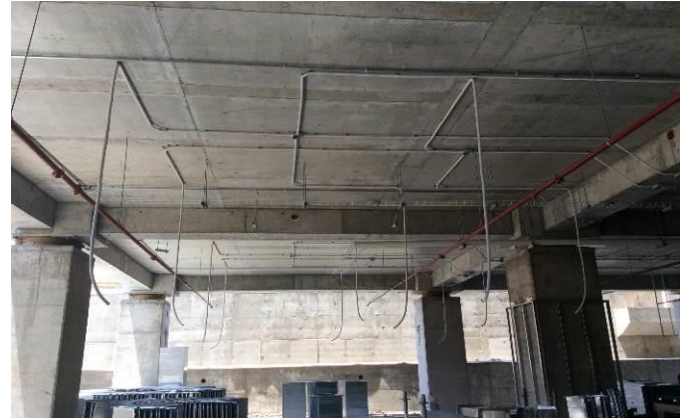
Losa hormigonada en edificio TH
