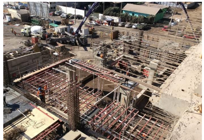
Últimos avances en la colocación de armadura sector de CDT
