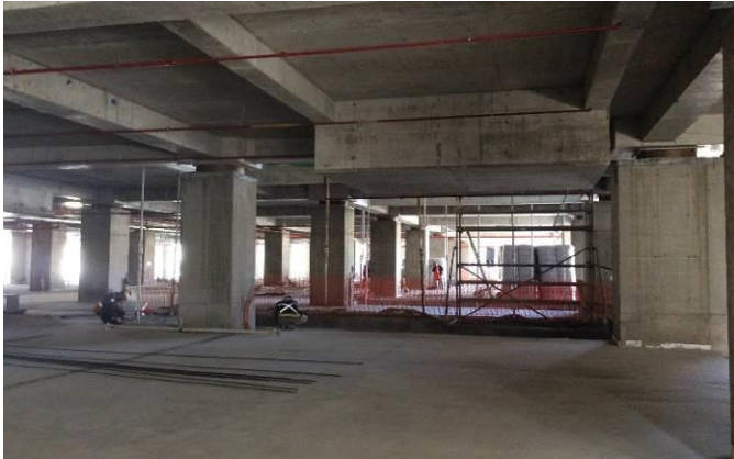
Grout en capiteles edificio CDT
