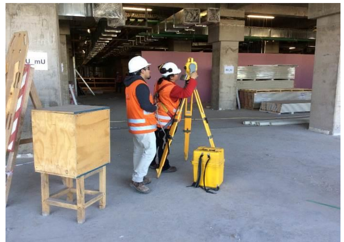
Control de nivel radier edificio UPC (post hormigonado)
