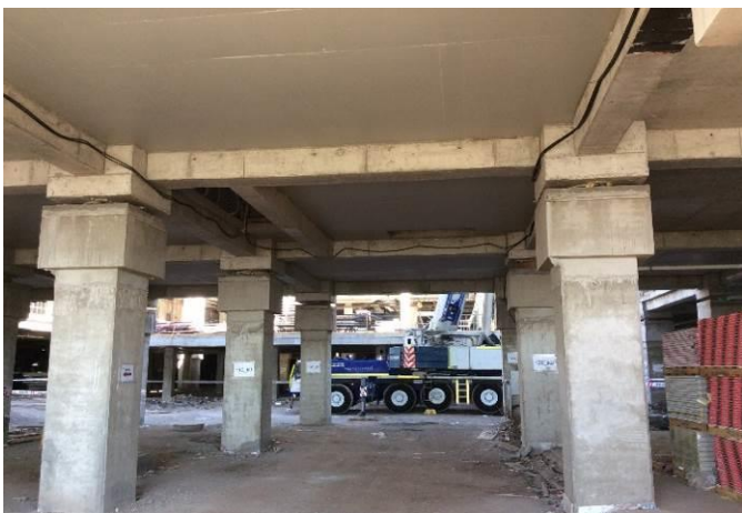
Avance losa hormigonada en edificio UPC
