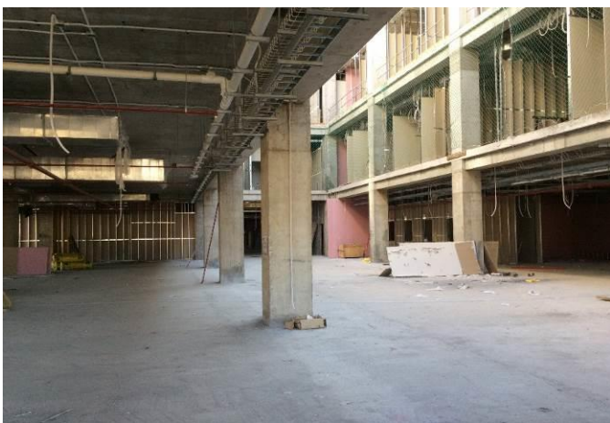
Losa hormigonada en edificio CDT
