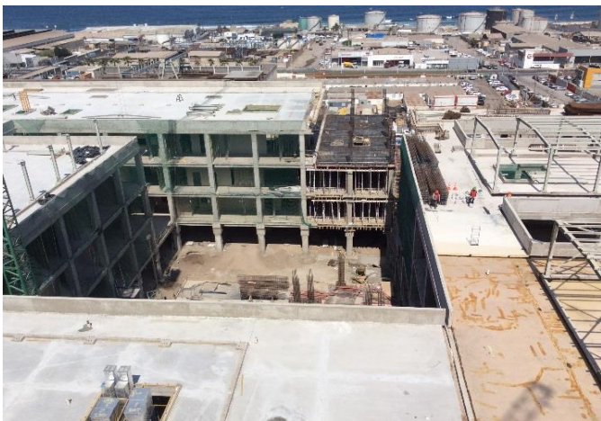
Avance en la colocación de hormigón en edificio Unidad de Pacientes Críticos UPC
