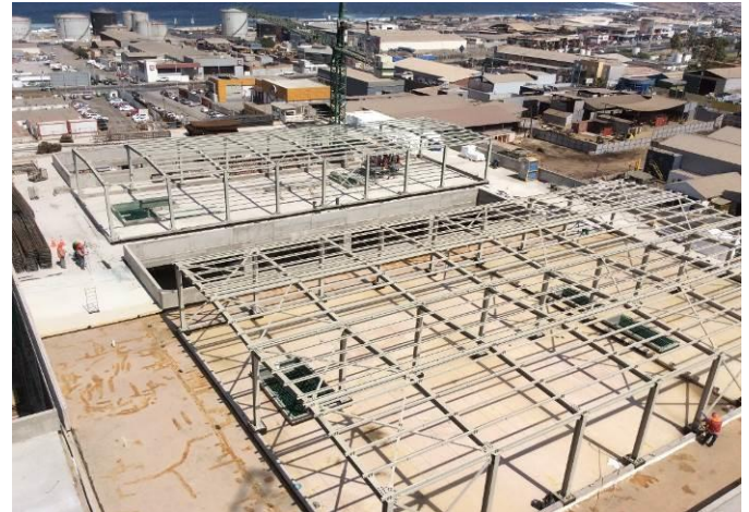
Avance impermeabilización cubierta edificio CDT
